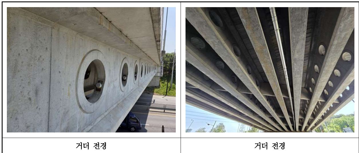
【사진 2.3.4】 거더 전경
