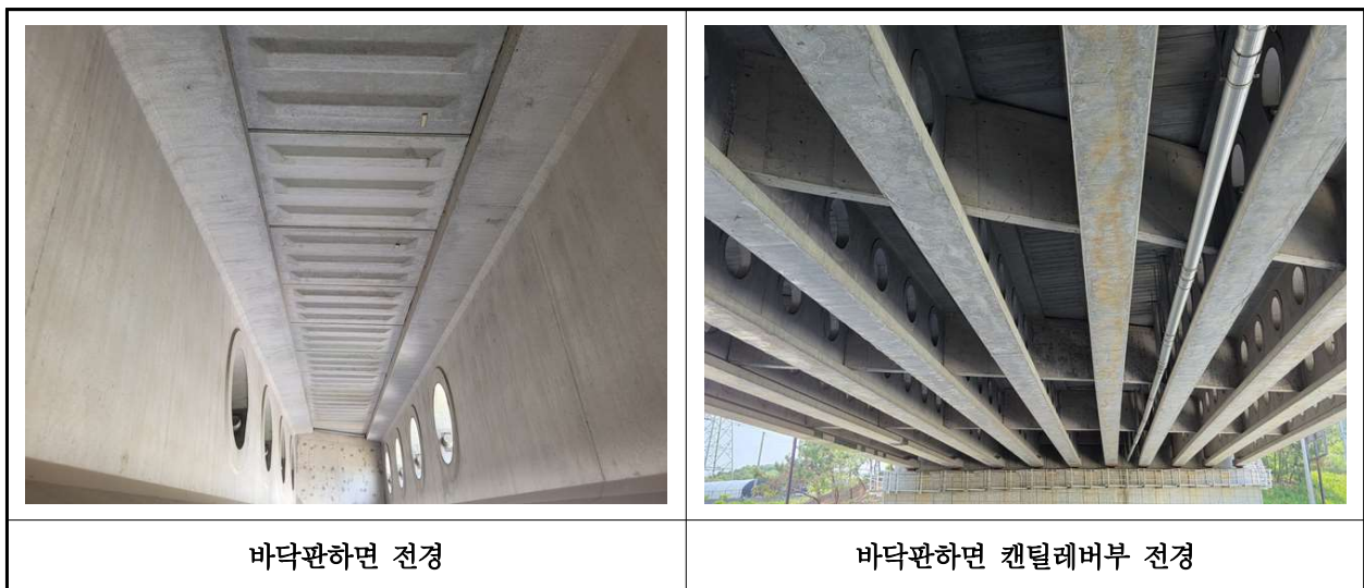
【사진 2.3.2】 바닥판하면 전경
