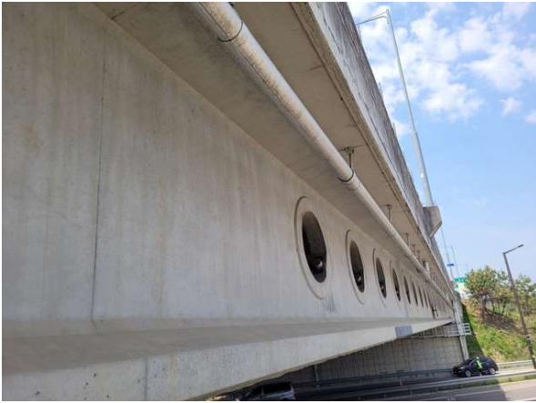
바닥판하면 S1 외측 캔틸레버 상태현황
