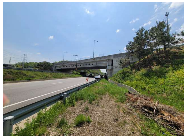
하부 교차 시설 전경
