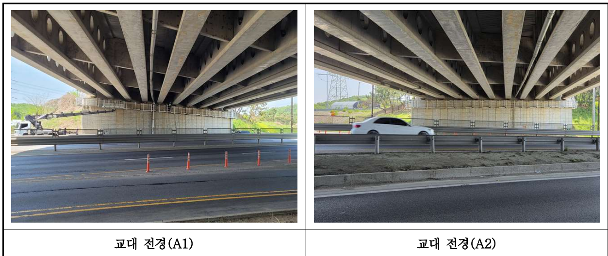
【사진 2.3.8】 교대 전경
