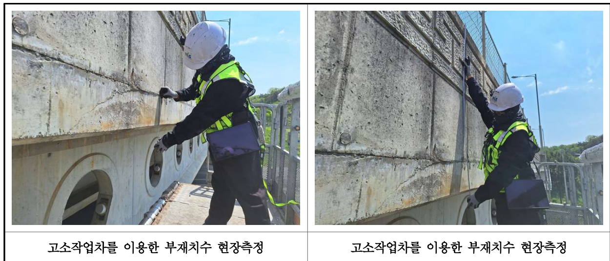
【사진 2.2.2】 부재 현장측정 전경
