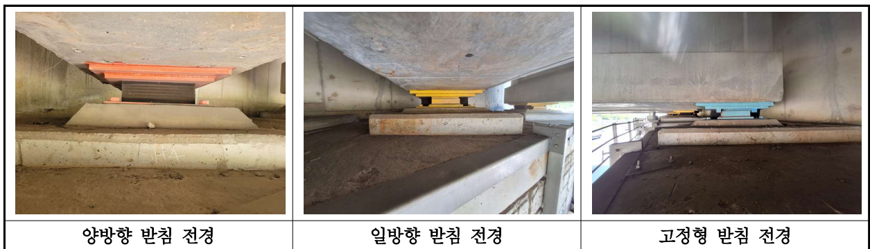
【사진 2.3.12】 교량받침 전경
