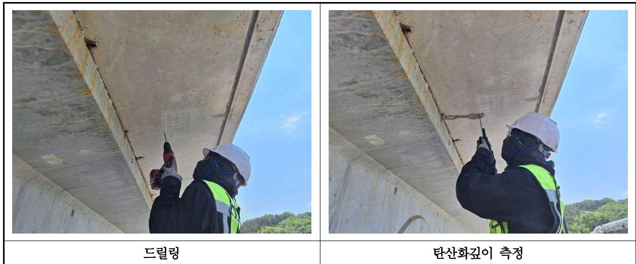
【사진 2.4.3】 탄산화 깊이 측정 현장사진
