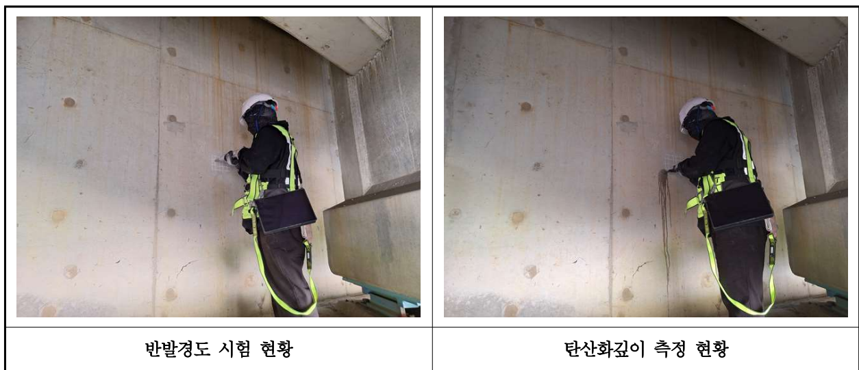
【사진 2.4.1】 콘크리트 내구성조사 현황
