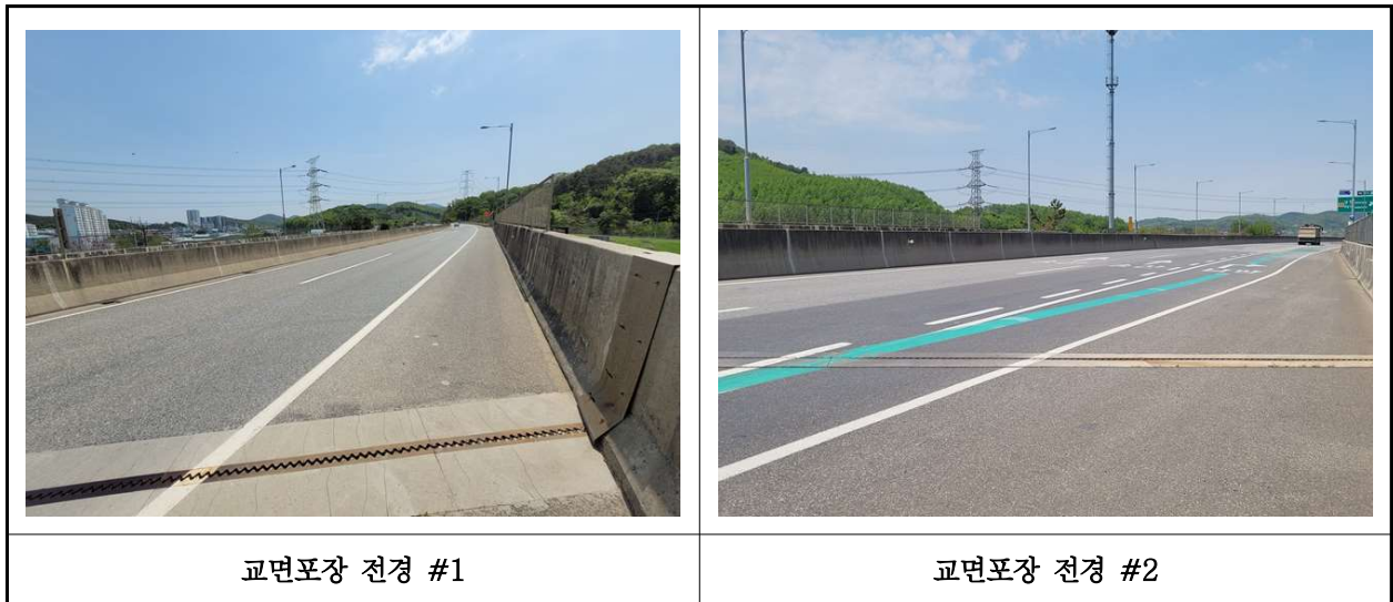
【사진 2.3.19】 교면포장 전경
