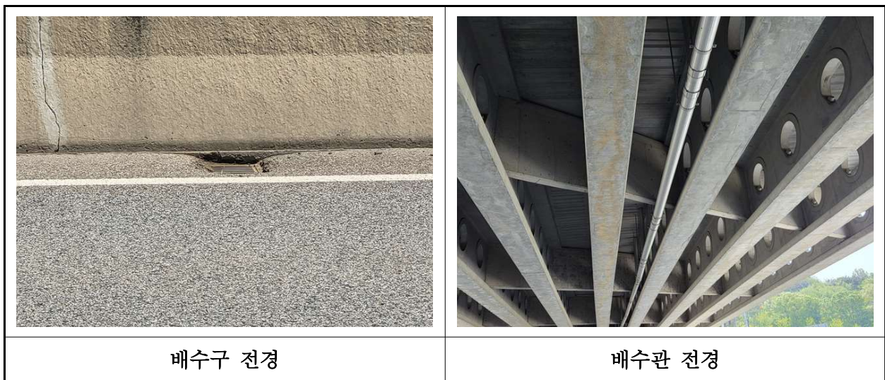
【사진 2.3.21】 배수시설 전경
