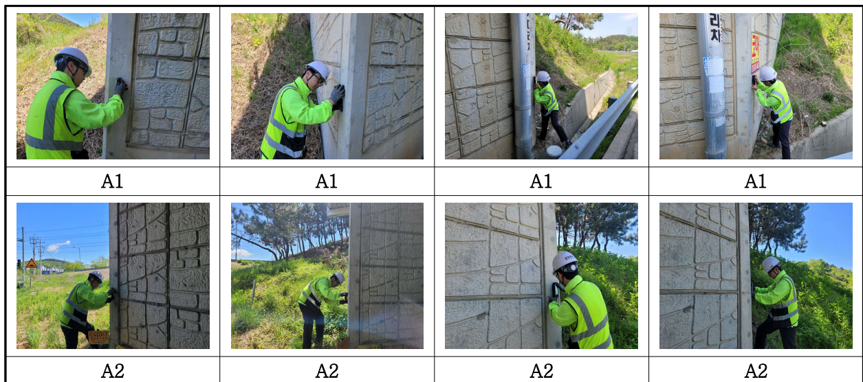
【사진 2.3.10】 교대 기울음 측정 현황
