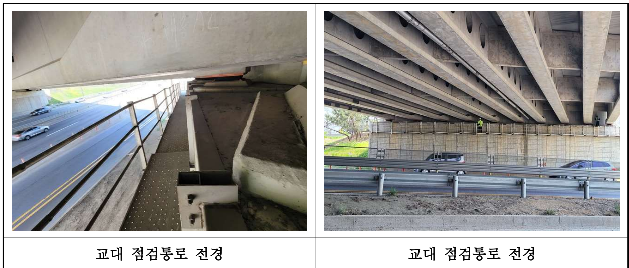
【사진 2.3.25】 교량 점검시설 전경
