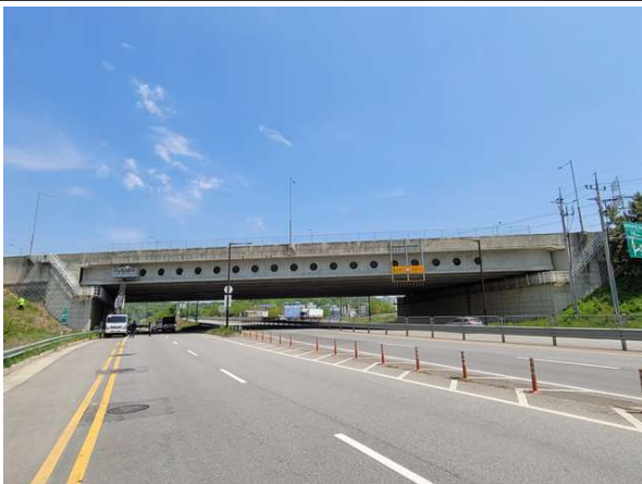
하부 교차 시설 전경
