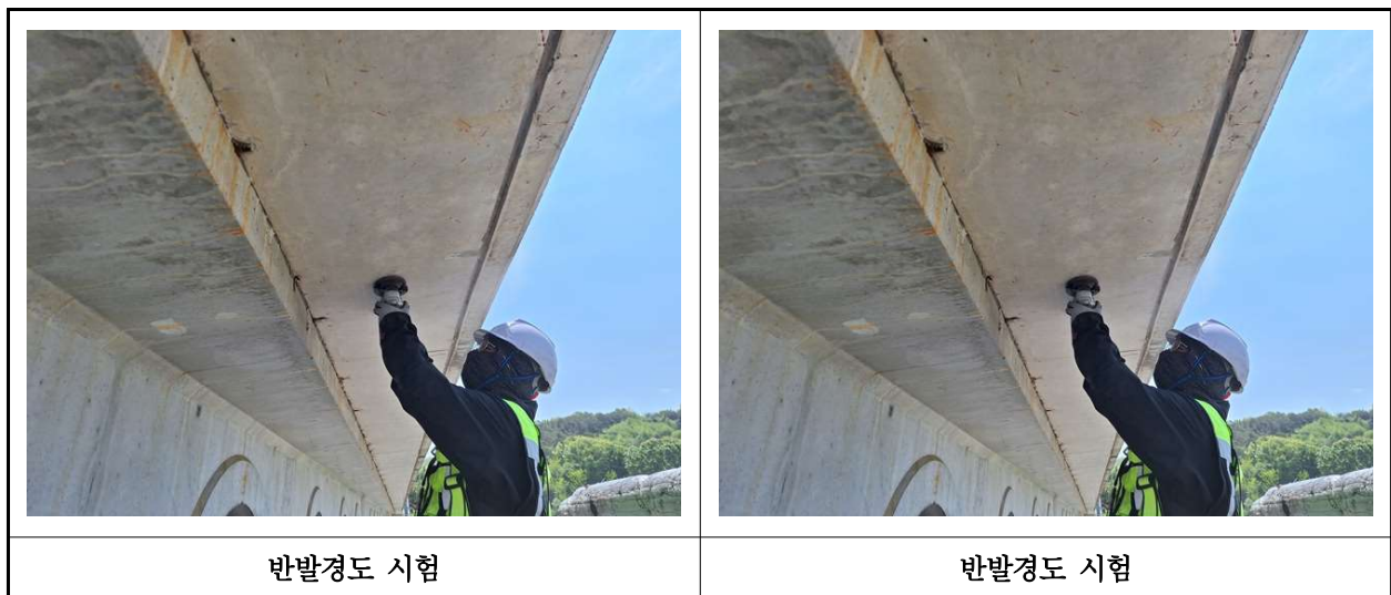
【사진 2.4.2】 반발경도시험 현장사진
